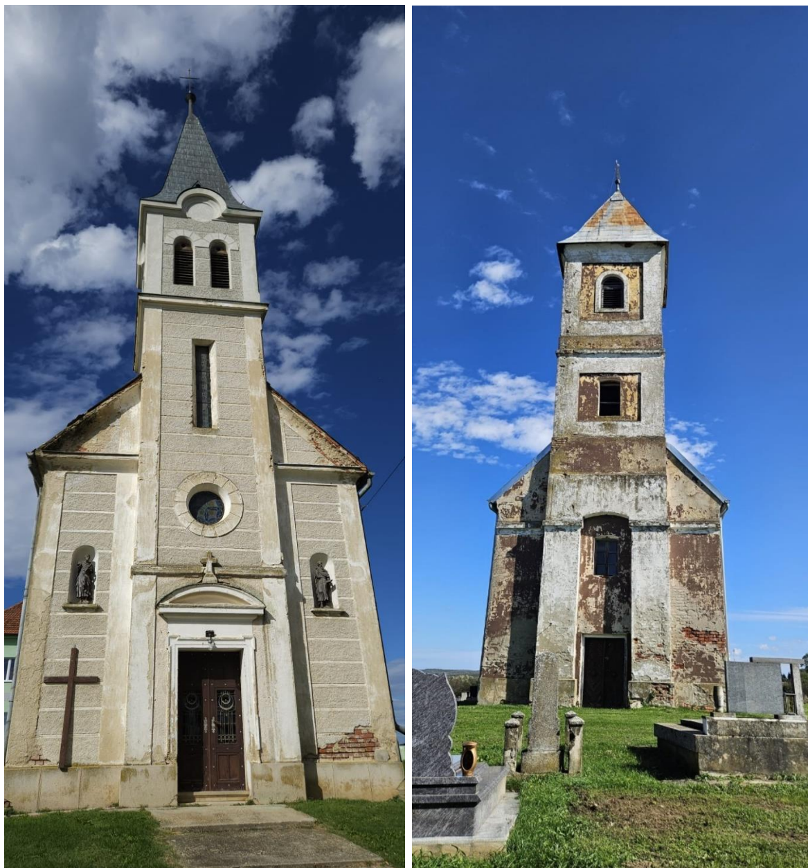
Slika 61. Kapela sv. Vida u naselju Slovinska Kovačica i Parohijska crkva Preobraženja Hristova u naselju Bedenik. Izvor: Level Project d.o.o.
